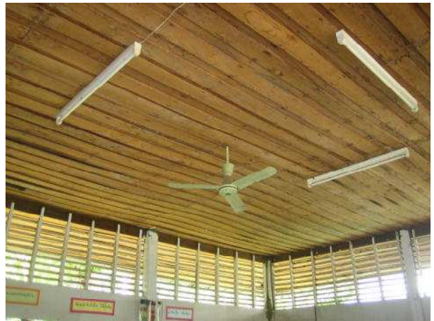
【教室の照明は3本だけ】
