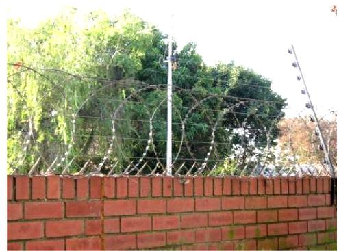
「写真右：住宅地や学校・公共施設の塀の上に敷設されているエレクトリックフェンス。（電線）9千ボルトの高圧電流が流れているので侵入防止になる。」これらの対策をしているので、この中は比較的安全だ。
