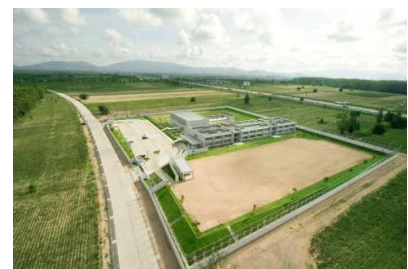
航空写真による校舎全景
