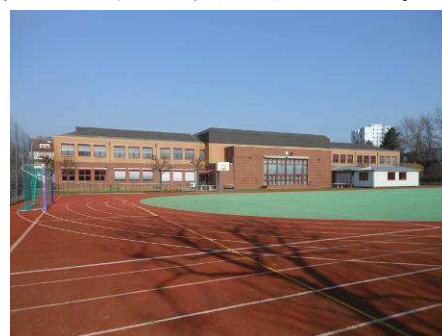
写真1 フランクフルト日本人国際学校校舎
